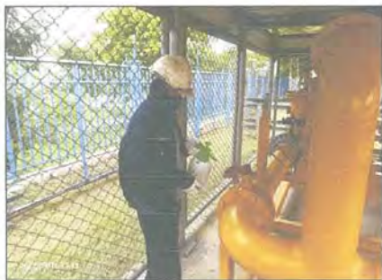
ทำการตรวจสอบและทดสอบระบบท่อภายในสถานี
